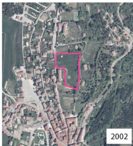
Urbanisation secteur de Bruchon Maison de retraite - environ environ 1 ha
