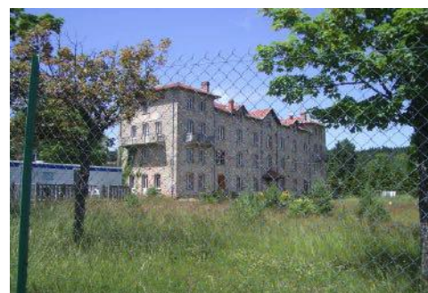
Ancien centre équestre « Azur Plein Air » transformé en logements privés
