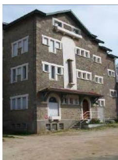
Copropriété privée de 7 logements
