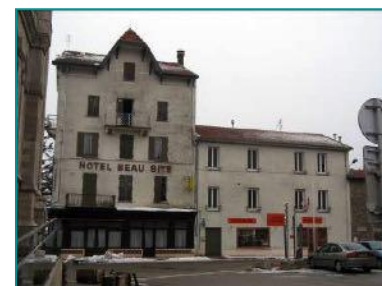
Ancien hôtel Beau Site (travaux d'aménagement d'appartements en cours + une galerie artisanale qui a été créée à droite)
